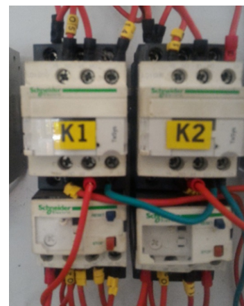
Gambar 8. Kontaktor dan Thermal Overload
