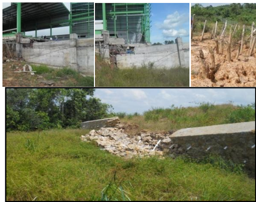
Gambar 3.2. Bukti adanya dua phase kelongsoran Tiang Beton miring kearah yang berlawanan dengan micropile
