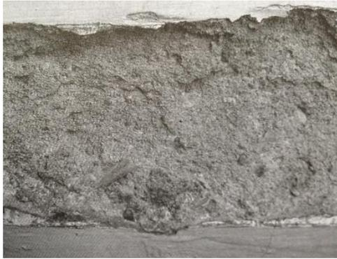
Gambar 1. Pengelupasan selimut beton
