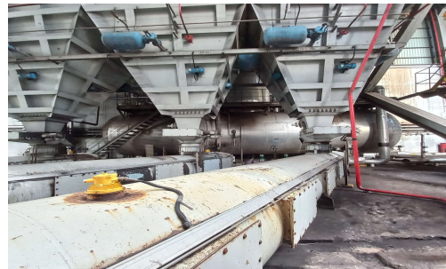
Gambar 1. Deaerator PLTU Teluk Balikpapan
