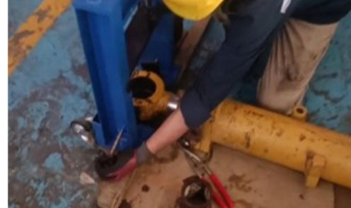
Gambar 17. Pengencangan guide bracket
