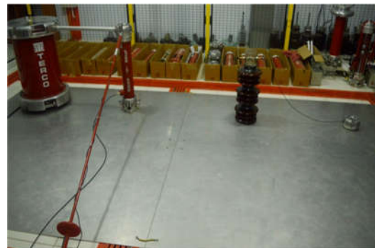
Gambar 4. Rangkaian Pengujian Tegangan Tembus Isolator
