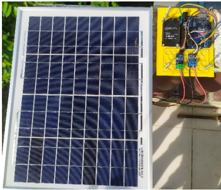
Gambar 4 Gambar Monitoring Solar Cell menggunakan mikrokontroler arduino
