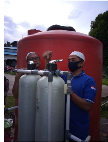
Gambar 4. Edukasi cara pengoperasian mini WTP kepada guru Ponpes Yasin
