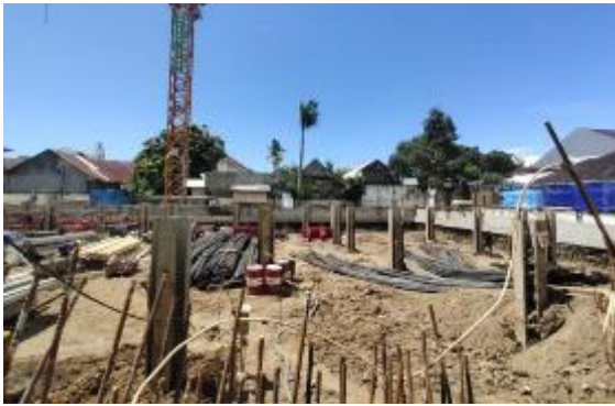
Gambar 6. King Post yang sudah terpasang
