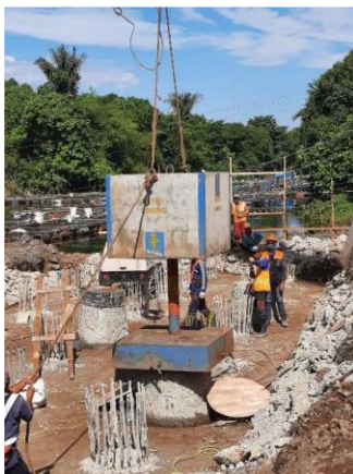
Gambar 4. Proses Uji PDA di Lokasi Penelitian
