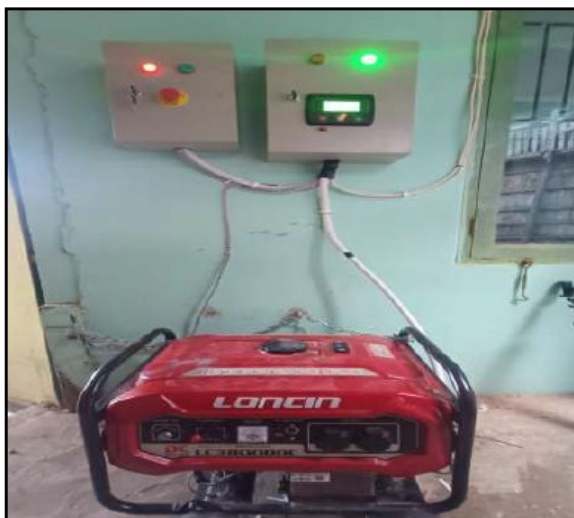
Gambar 2. Rangkaian Sistem ATS pada Mushola
