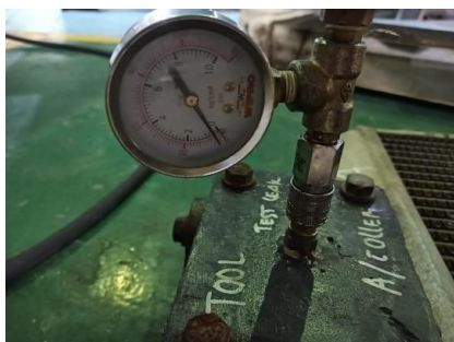
Gambar 3. Proses pengujian tool test leak dengan tekanan angin
