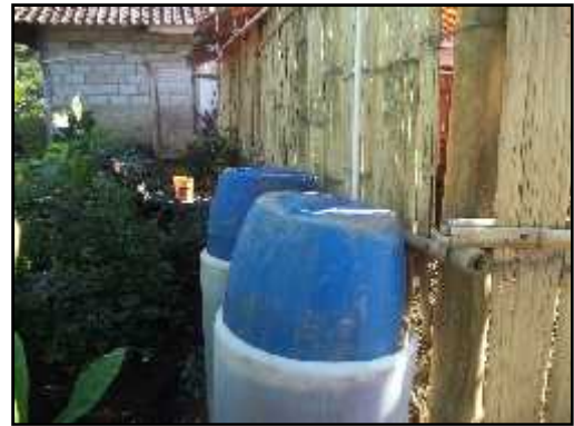
Gambar 10: Penampung Gas, jika sudah terisi penuh maka tong akan naik karena dorongan gas (Sumber : UP – FMA Bhakti Muda Banjarnegara.)
