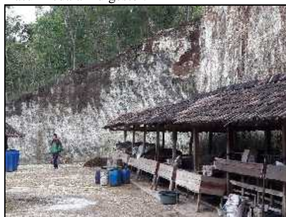
Gambar 3: Konstruksi Kandang di Desa Monggol
